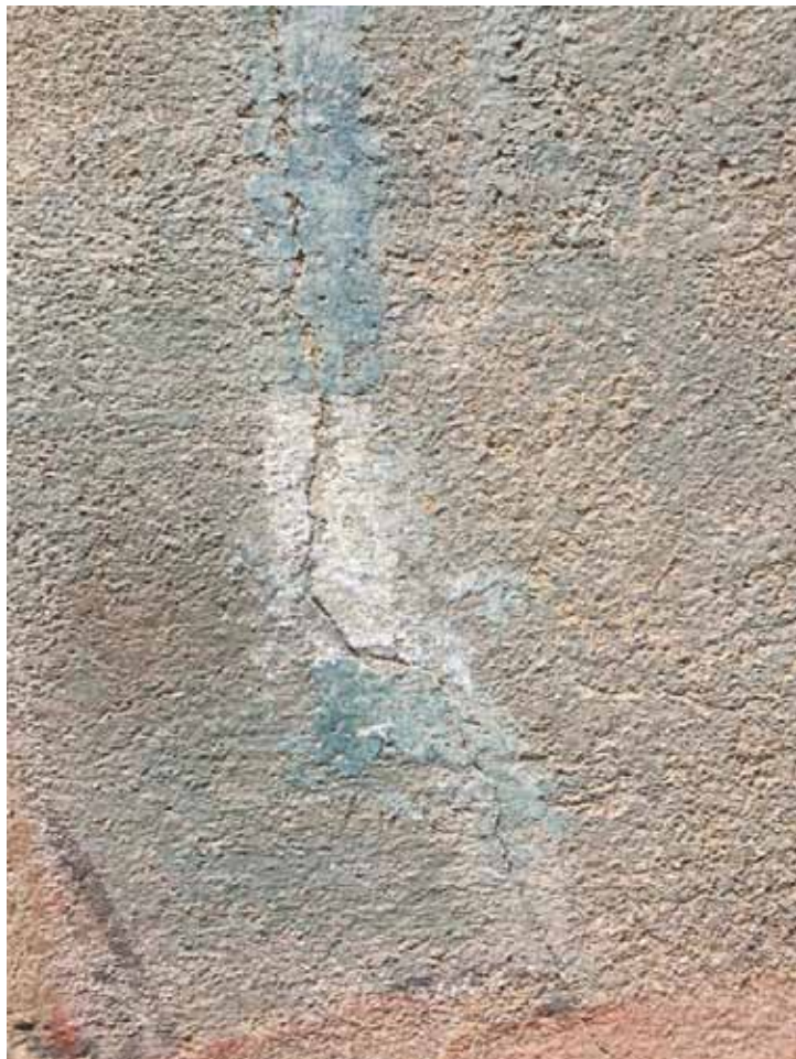
sonda - odstraňování retuše a nevyhovujícího tmelu z okolí prasklin
