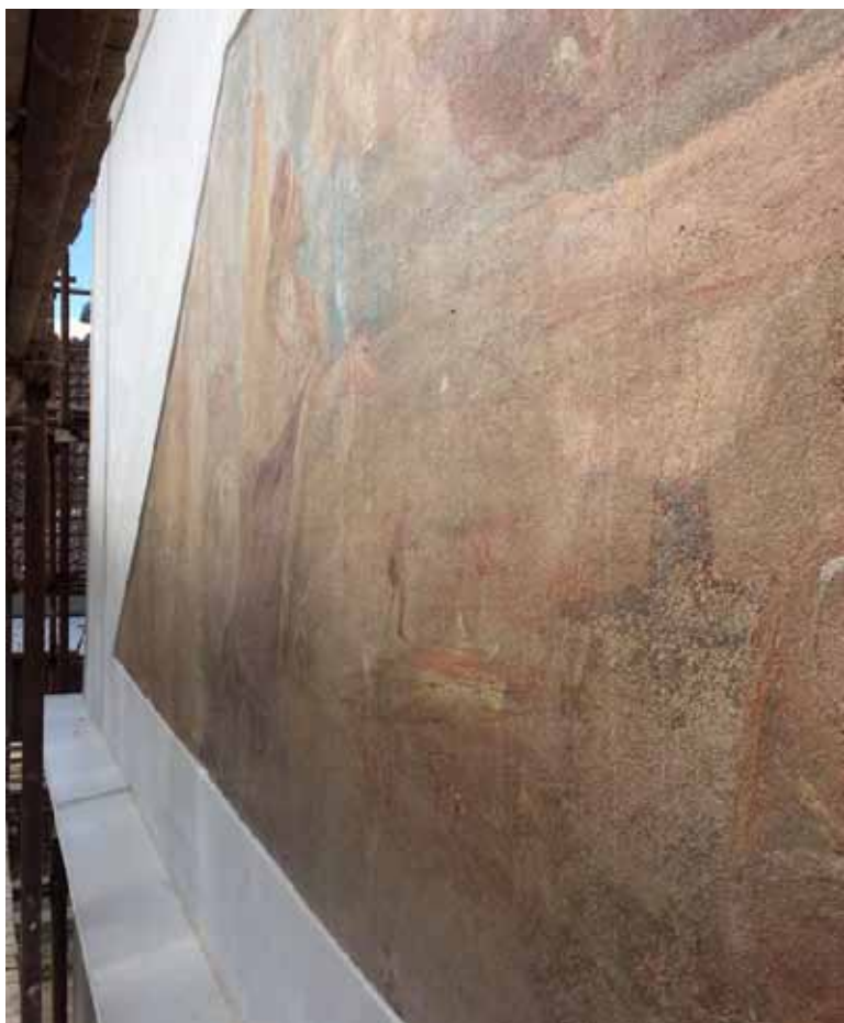
celky focené z lešení, stav před restaurováním
