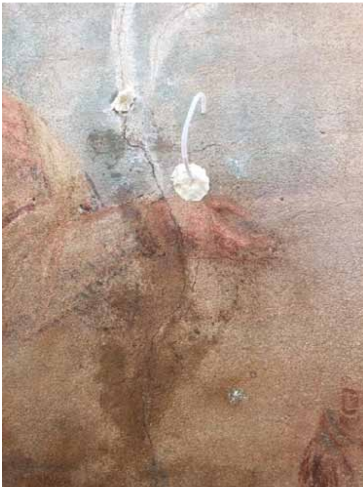
detail injektáže prasklin
